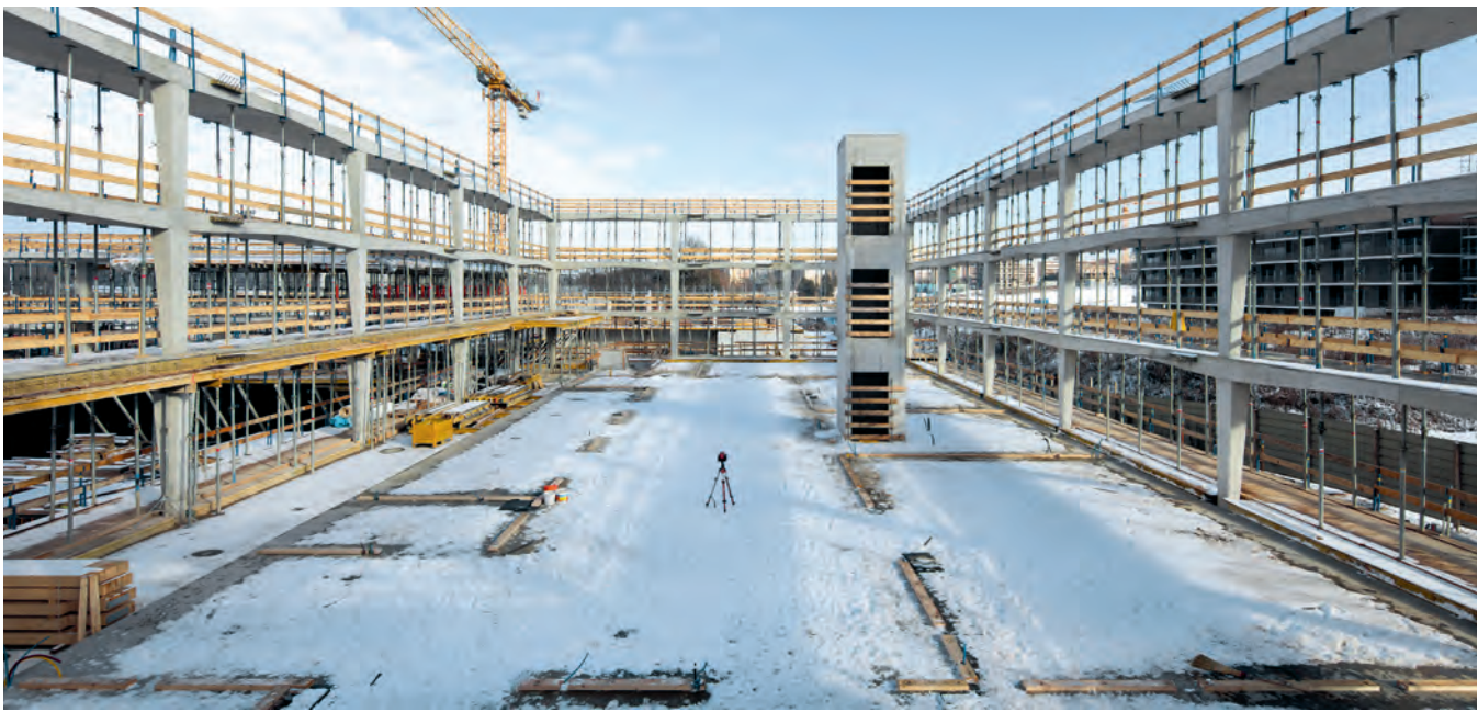
Zuerst wurden die Betonbalkone und der Liftschacht an Ort gegossen, anschliessend der Holzbau aufgestellt.
