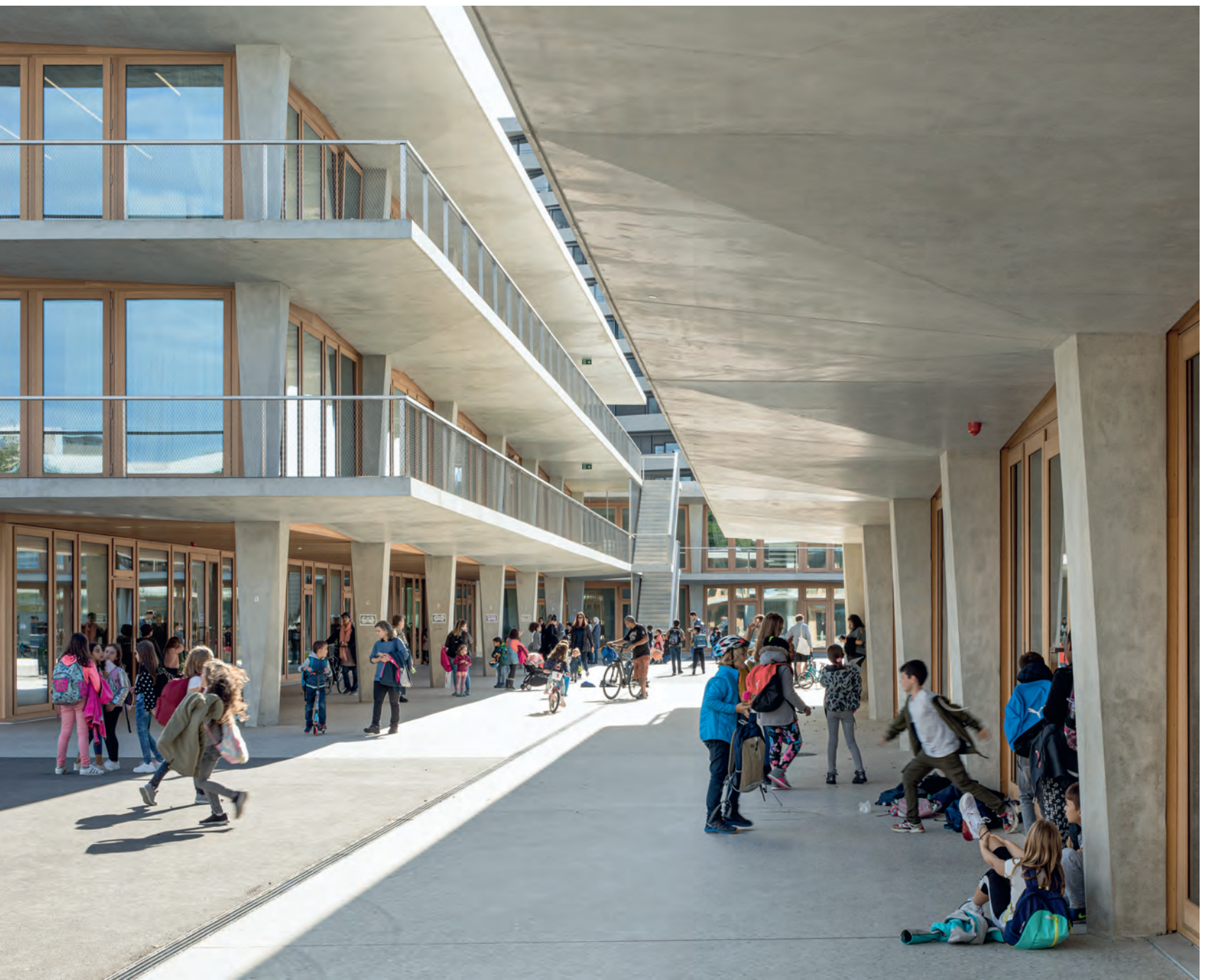
Die umlaufenden Betonbalkone prägen das Äußere der Schulanlage Les Vergers in Meyrin. Vier Gebäude erzeugen ein Geflecht von Höfen und Gassen.
